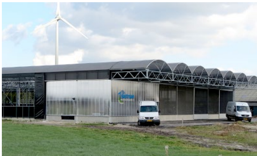
Serredak met veel aandacht voor architectuur; doorlopende voorgevel, glazen wand en tanklokaal Dit dak kan open en dicht door oprolgordijn
